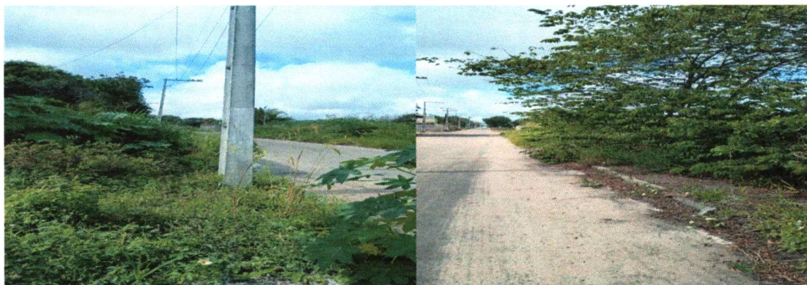
Fotos das Vias do Distrito Industrial
